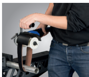
Levigatura di acciaio tondo con tela velcrata, ad es. parapetti in acciaio inox già montati
