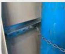
Catene di sicurezza per fissaggio bombole
