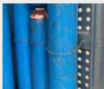
Catene di sicurezza per fissaggio bombole
